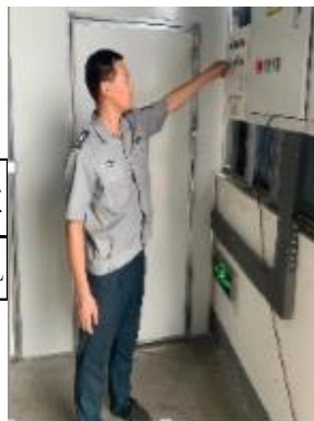
(5)检测数据合格后，停止冲 洗，将冲洗水抽至污水区处 理。
