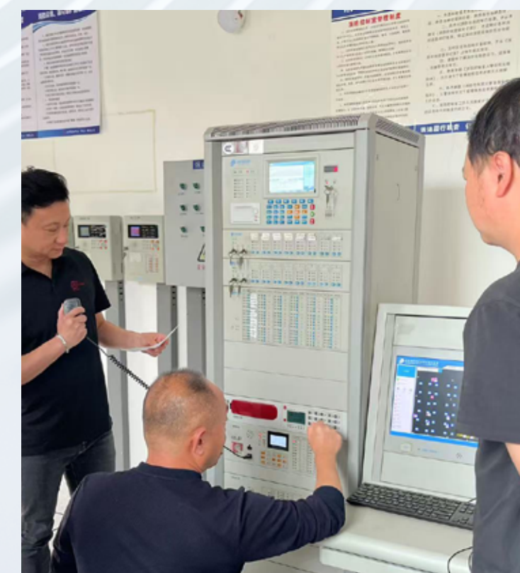
昆山－消防設備操作及疏散演練
